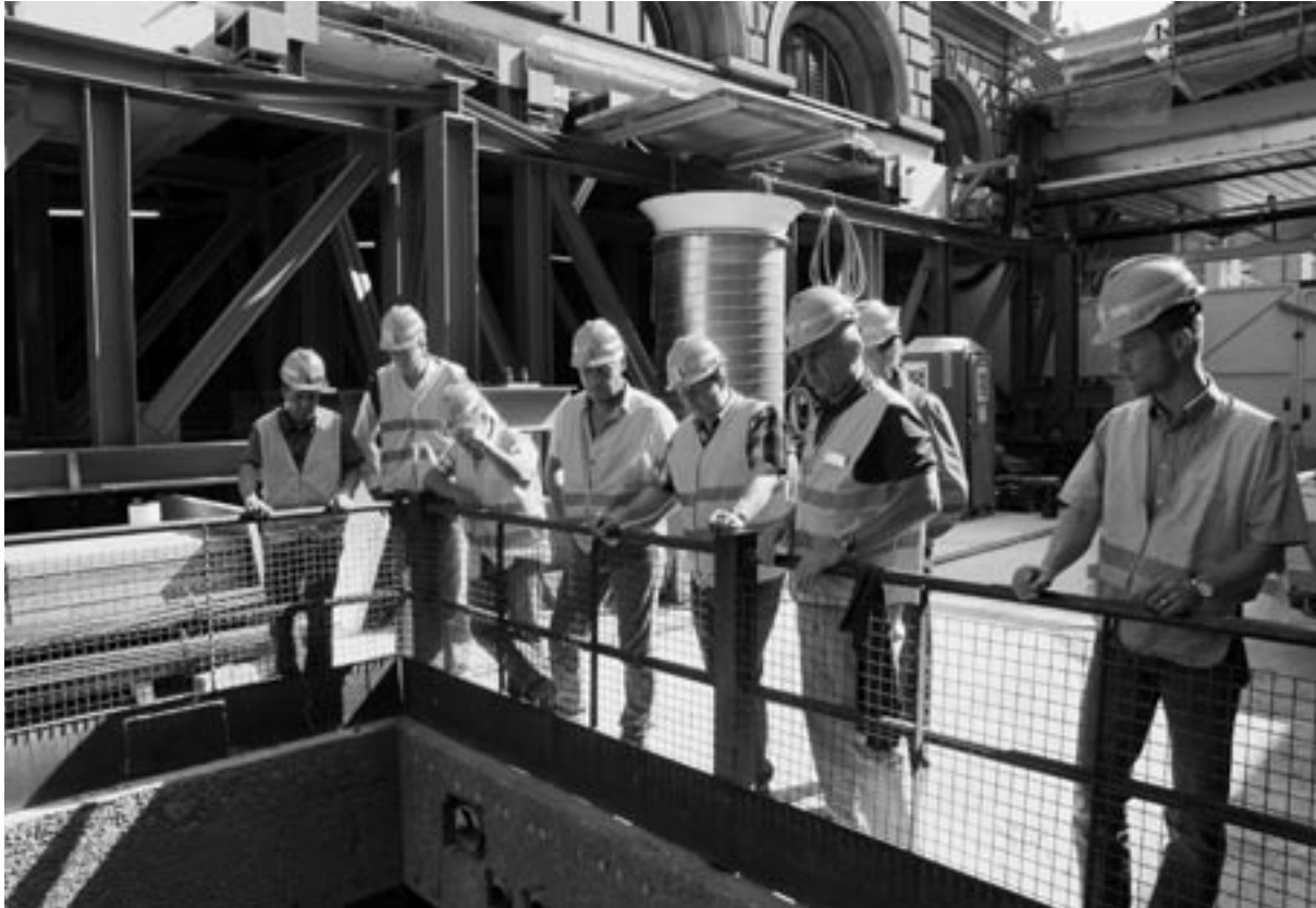
Bauverwalter beim Betrachten der Durchmesserlinien-Baustelle in Zürich
